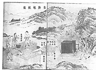
(宋應星《天工開物》中所繪的『生熟煉鐵爐』)
